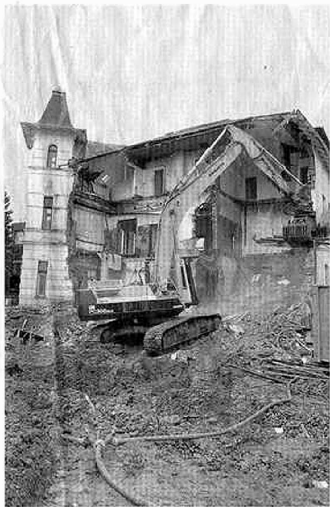
DIE ALTE HOMANN-VILLA an der Bahnhofstraße drohte zu zerfallen. Gestern rückte ein Bagger an, um das Gebäude abzureißen. Eine Sanierung wäre unwirtschaftlich gewesen. Foto: Simone Grawe
