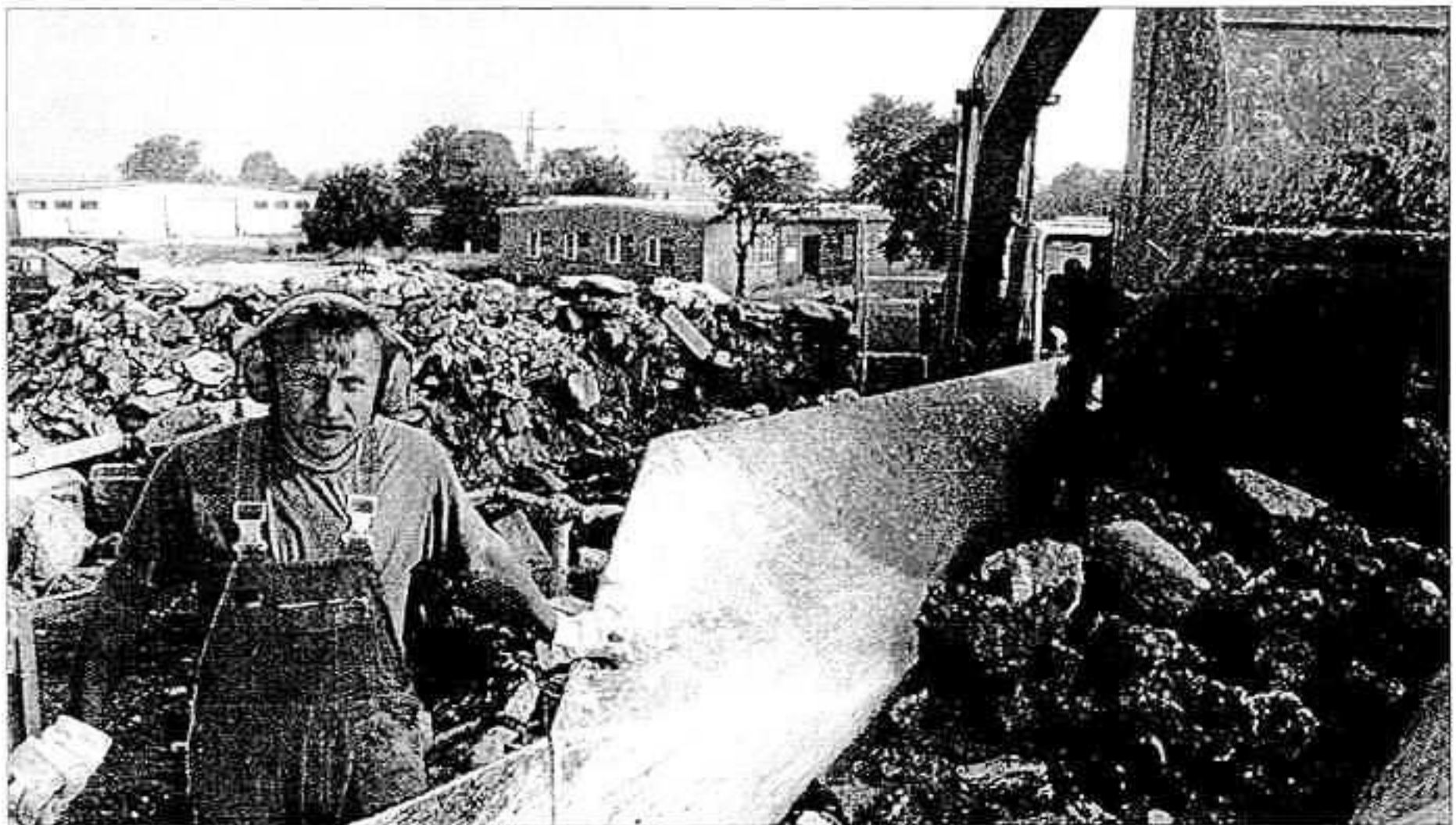
Staub, Dreck und die richtigen Ohrenschützer gehören für Waldemar Neimann auf der Brecheranlage zum Arbeitsalltag. Im Hintergrund versorgt Wolfgang Look die Recycling-Maschine stets mit neuem Bauschutt. • Foto: Christian Tusch
