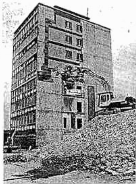
SONDERMÜLL gab es an der Fassade reichlich – die Entsorgung dauerte Wochen.
