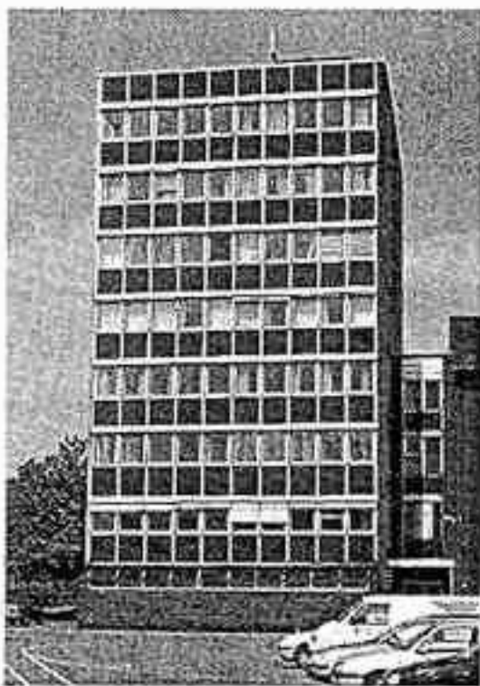
DREI JAHRZEHNTE lang arbeitete hier der TÜV.
