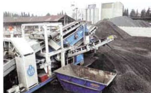
Dienstleistungsaufträge, bei denen die RC-Granulatoren zum Einsatz gebracht werden, haben maßgeblich auch die Unternehmensausrichtung geprägt. Fotos: Heitbrink
